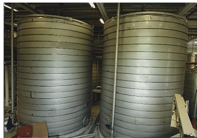
2-trins MBBR med bakterier
